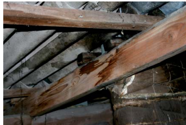
Opfugtet spærtræ og lægter
